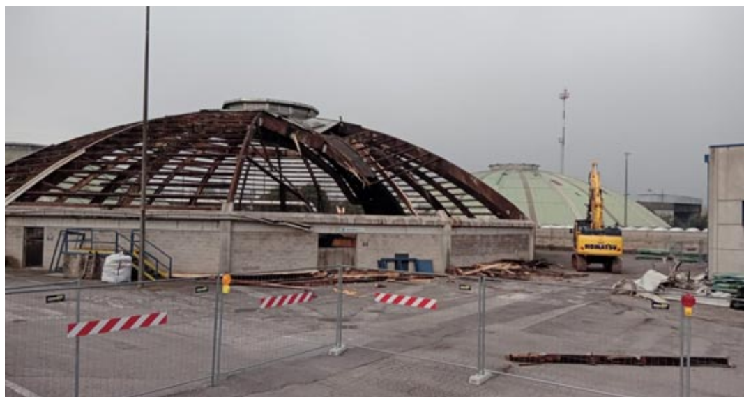
I lavori di Acque Veronesi al depuratore di Basso Acquar
