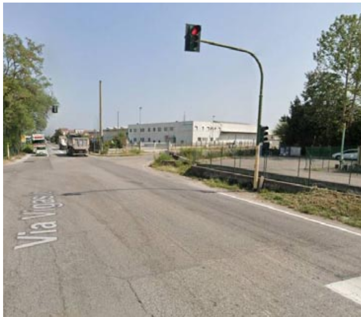
Partiti i lavori per la rotatoria in via Vigasio
