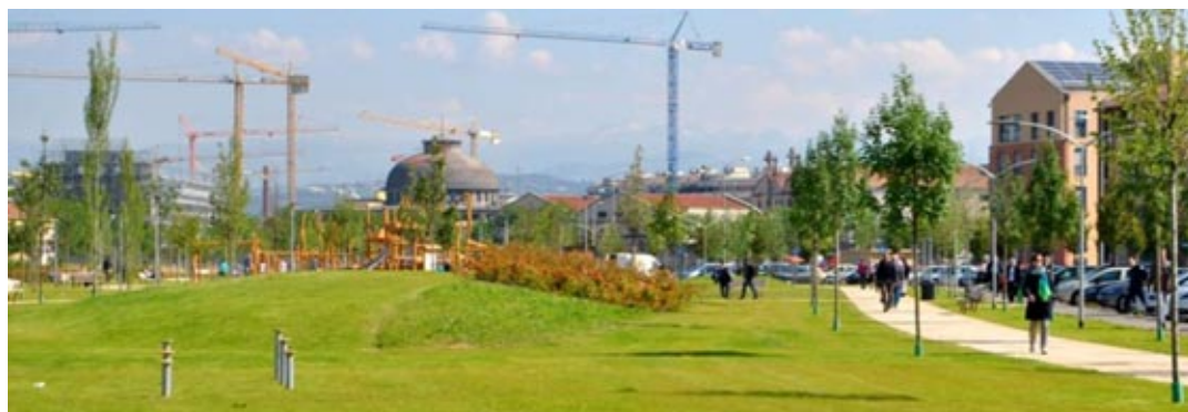
Partono i lavori per l'ampliamento del Parco Santa Teresa
