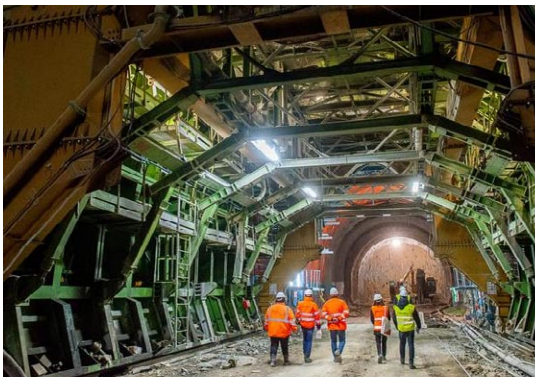
Completato lo scavo della Galleria San Giorgio per l'alta velocità Brescia Est-Verona
