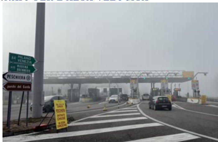
Dal 10 gennaio il casello di Peschiera chiuderà per almeno 24 giorni per lavori legati all'alta velocità
