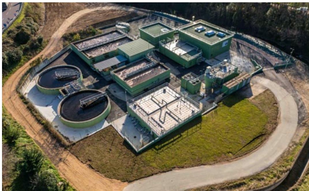
Il nuovo depuratore di Affi riqualificato da Azienda Gardesana Servizi
