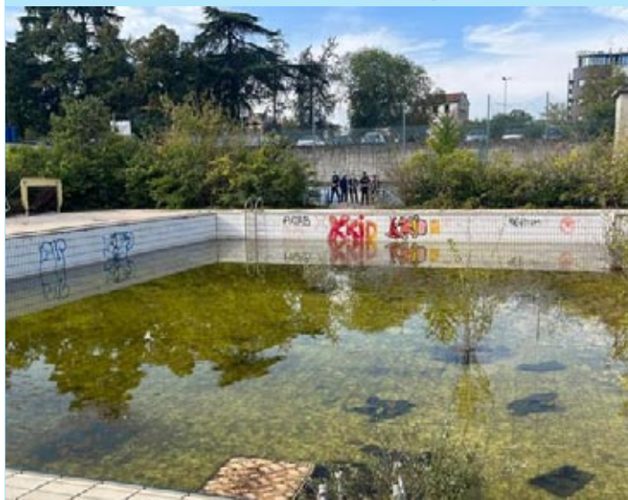
Le ex Piscine Lido in viale Galliano
