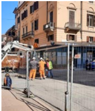
Lavori in via San Paolo
