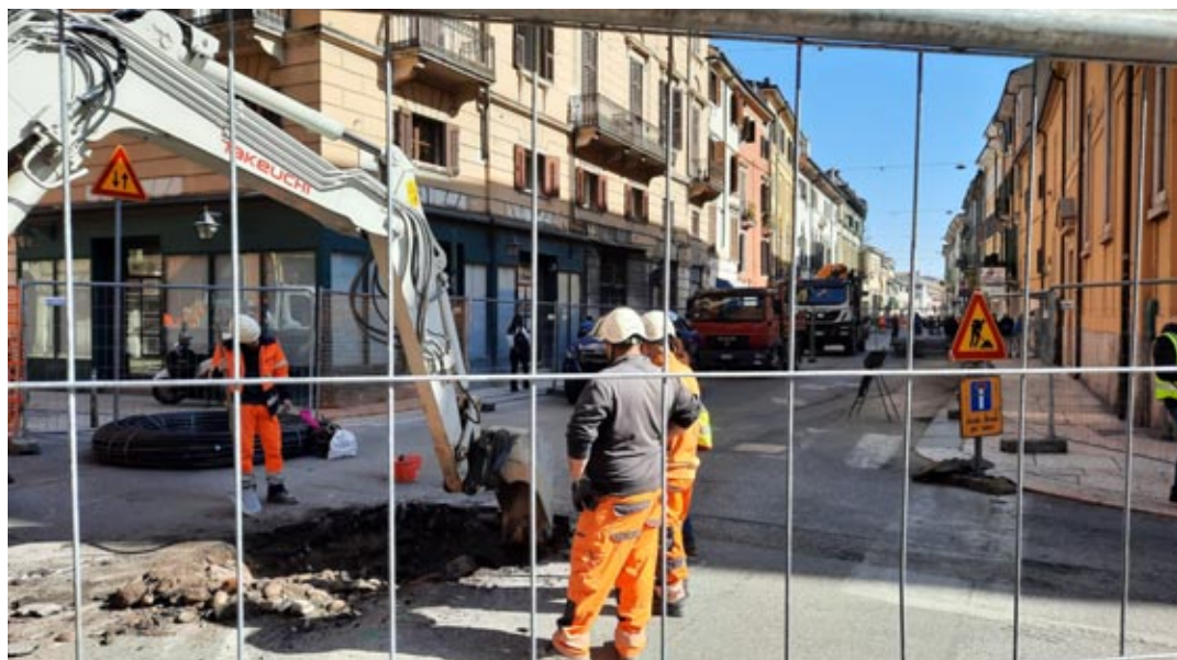
I lavori del maxi cantiere tra via San Paolo e via XX Settembre
