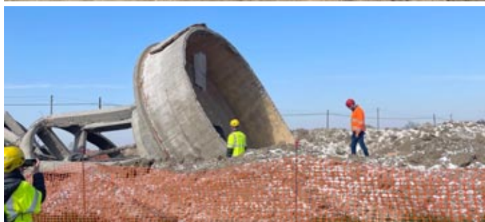
Il vecchio torrino di Minerbe è stato abbattuto
