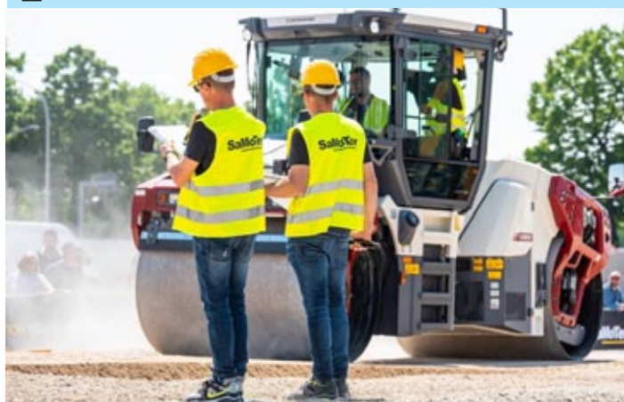
Lavori di pavimentazione stradale
