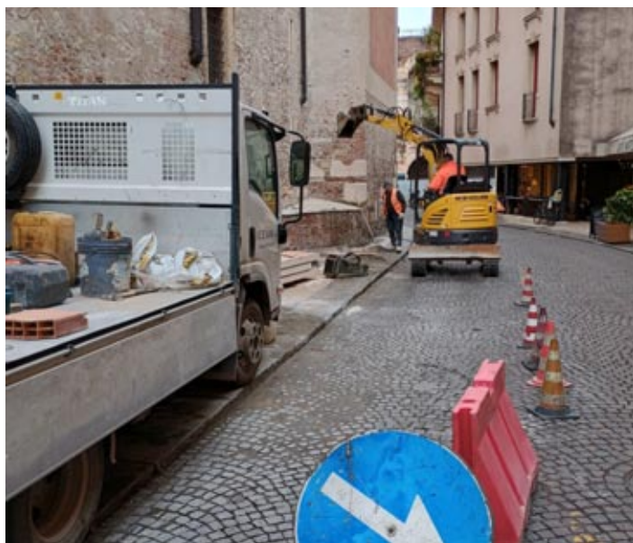
I lavori in Via Anfiteatro per le barriere architettoniche
