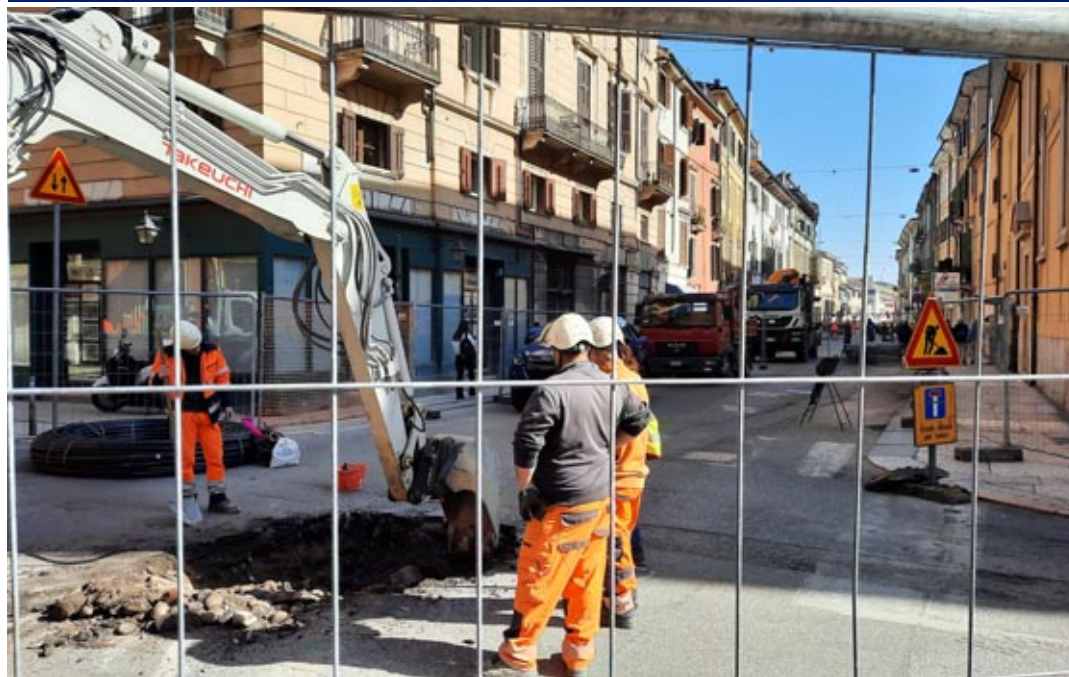
I lavori nel primo tratto di Via XX Settembre
