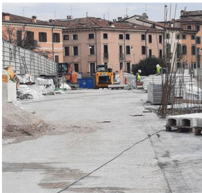
I lavori sul Ponte Nuovo
