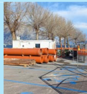
Lavori per il collettore
