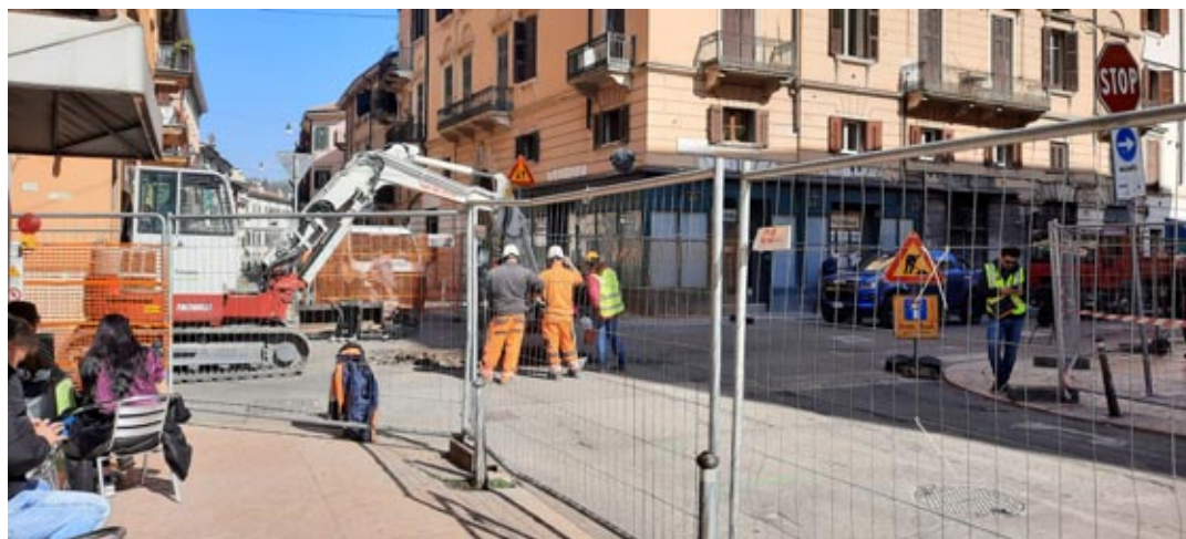
Terminata la prima fase del cantiere in Via San Paolo
