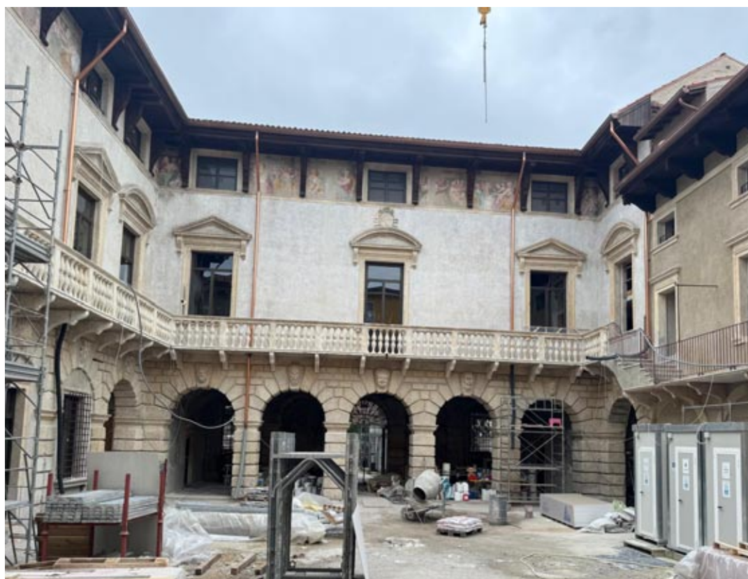
Terminati i lavori sulla facciata di Palazzo Bocca Trezza
