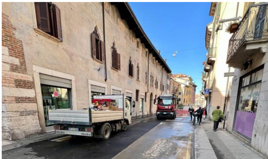
Il tratto di via San Paolo libero dal cantiere
