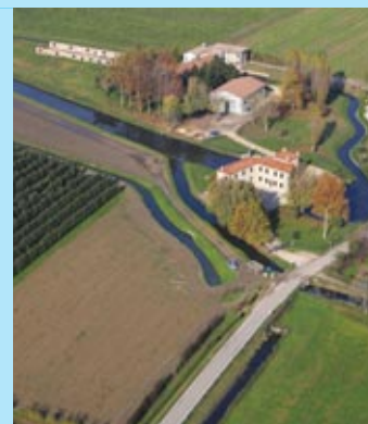
Il manufatto idraulico del Gangaion
