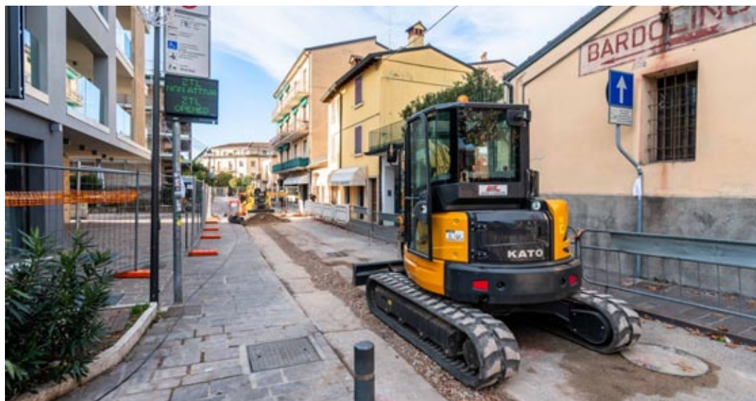
I lavori a Bardolino di Azienda Gardesana Servizi
