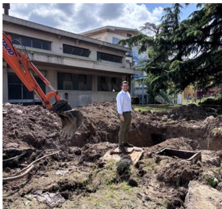
Il sindaco Matteo Pressi nell'area del cantiere
