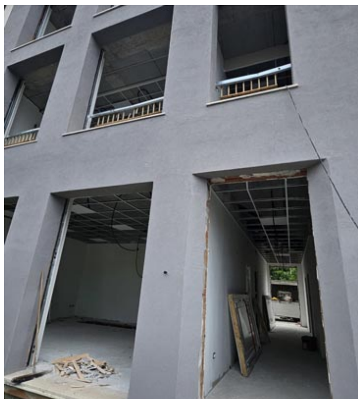
Il cantiere per riqualificare gli appartamenti dell'ex ca- serma dei Carabinieri in Corso Venezia a San Bonifacio
