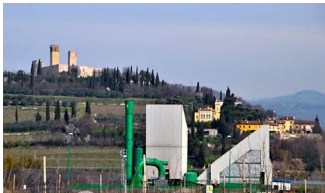
La Superbeton a Montorio
