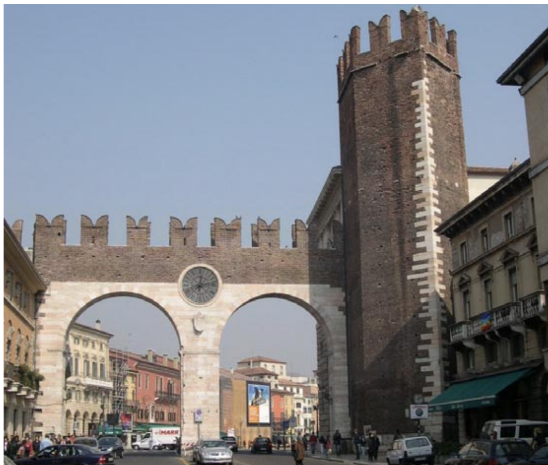
Dal 9 giugno iniziano i lavori di restauro dei portoni della Bra
