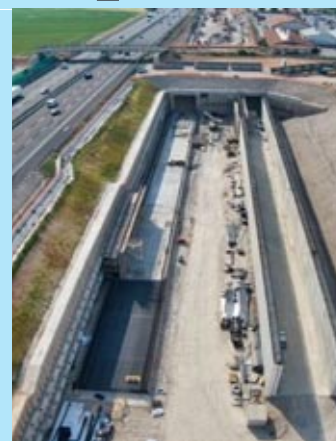
I lavori per l'Alta Velocità
