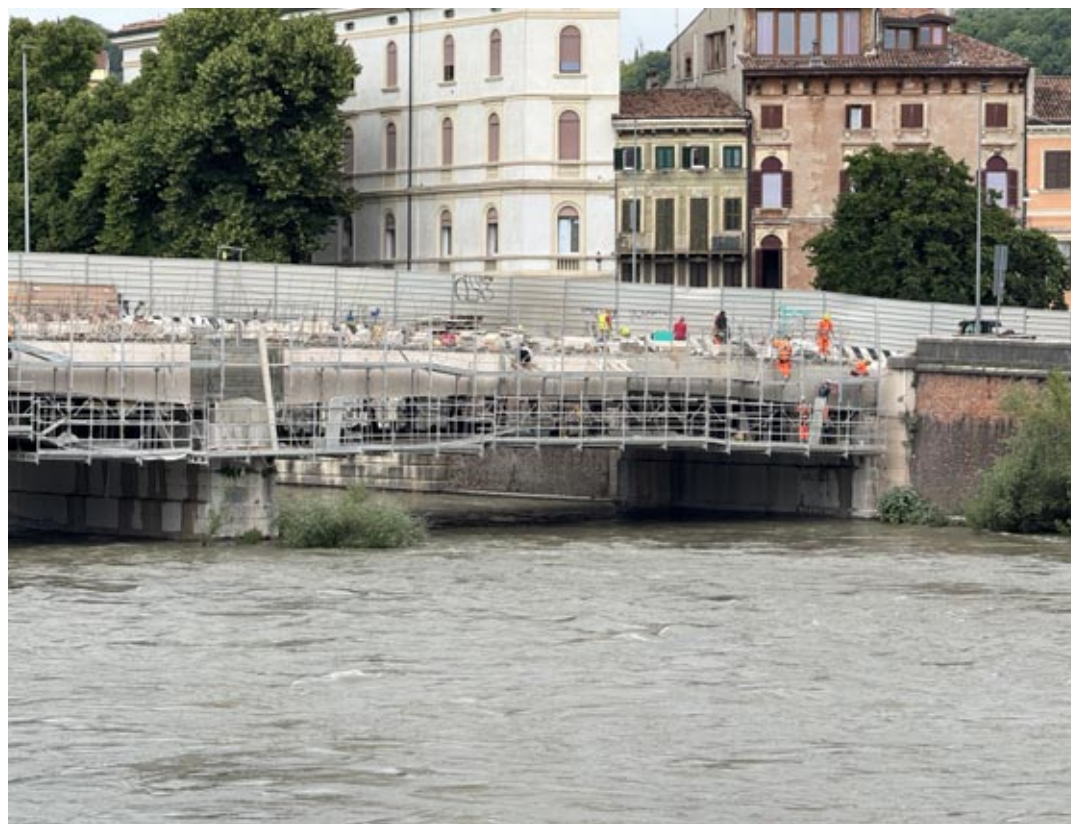
Per precauzione il ponteggio di Ponte Nuovo è stato sollevato
