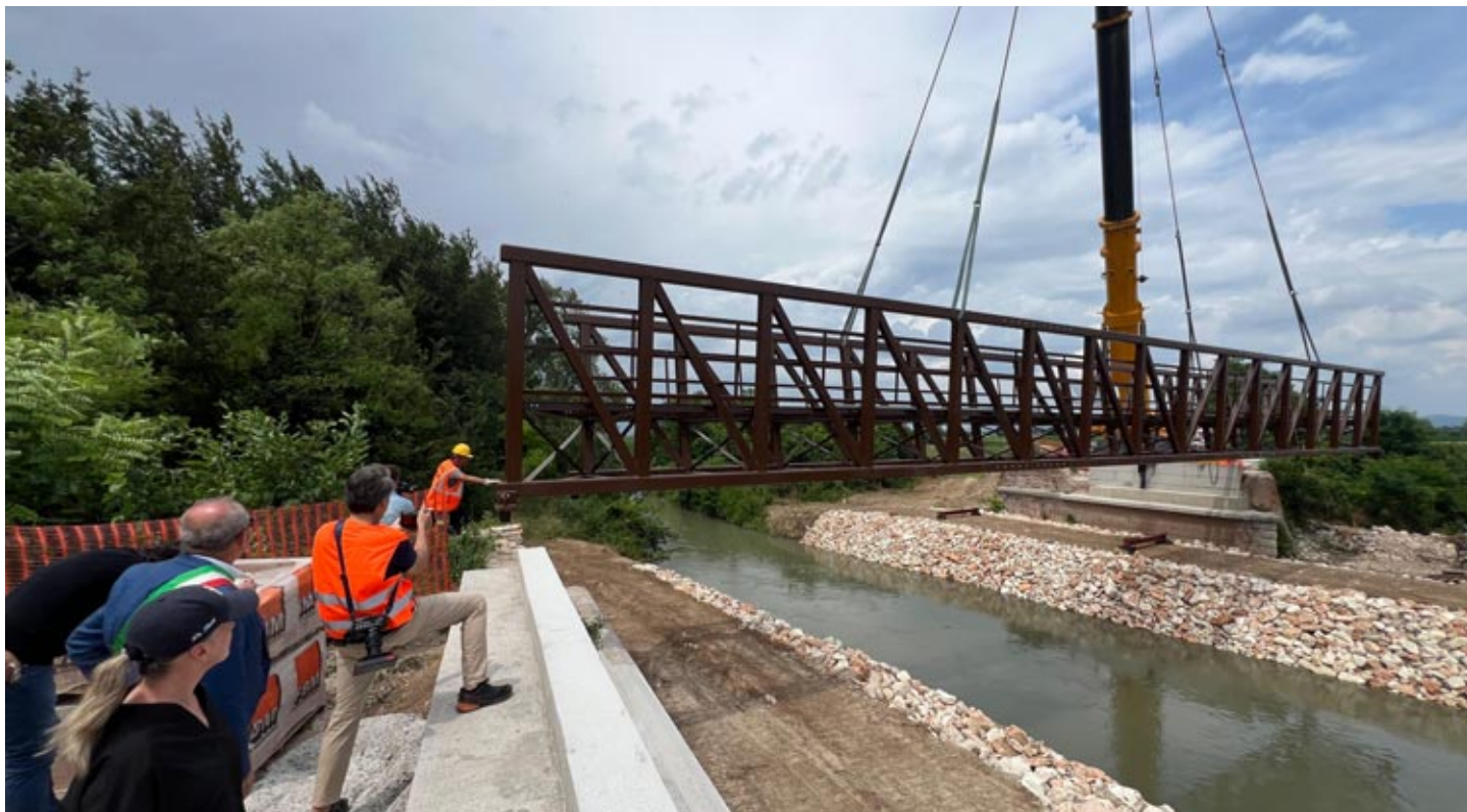
La posa della passerella sul Fratta a Pressana
