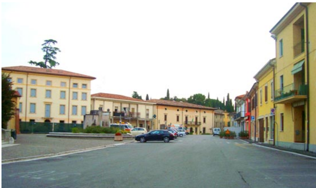
Il Comune di Sona ospiterà un maxi impianto di accumulo energetico
