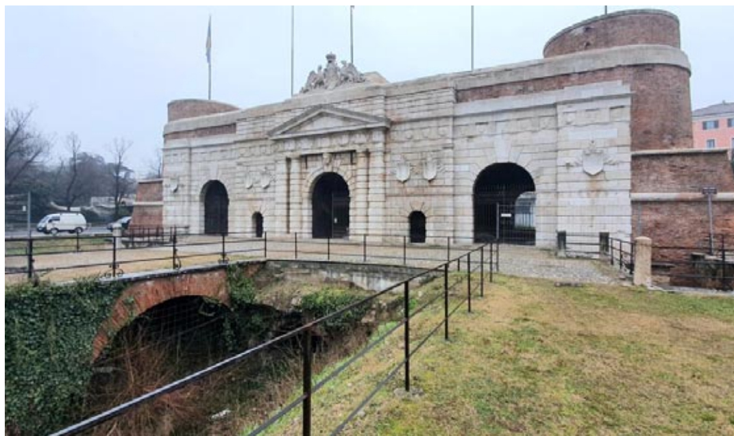
A Porta Nuova si registrano infiltrazioni di acqua piovana
