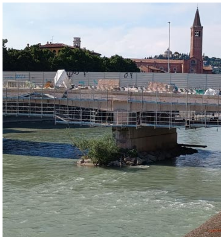
Al cantiere di Ponte Nuovo è spuntata anche una tenda
