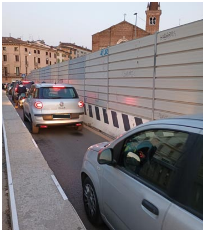
Ponte Nuovo da domani chiuso al traffico automobilistico
