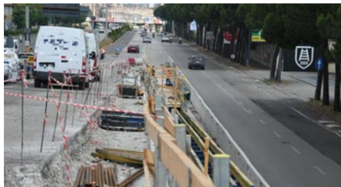
Il cantiere sul cavalcavia di Viale Piave
