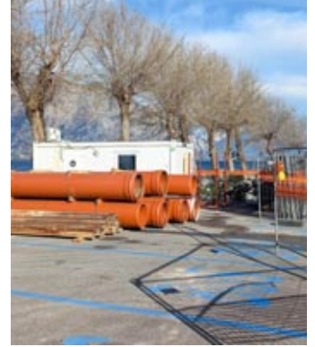
I lavori per il collettore
