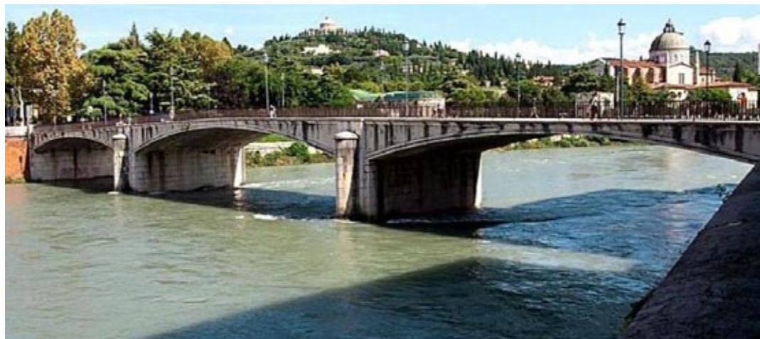
Arriverà a Ponte Garibaldi la pista ciclabile che parte da Parona
