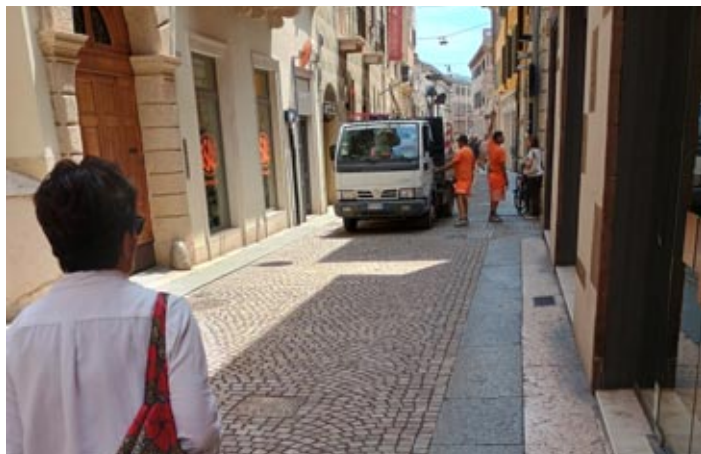
Via Quattro Spade pronta alla riapertura
