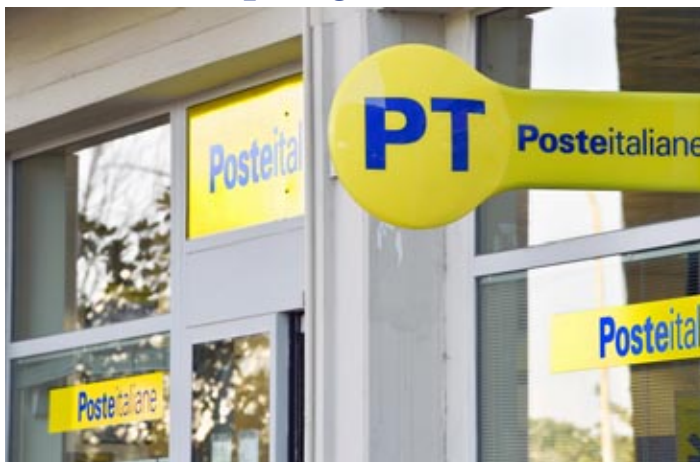
Lavori in corso all'Ufficio Postale
