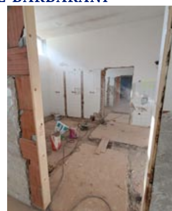
I lavori negli spogliatoi
