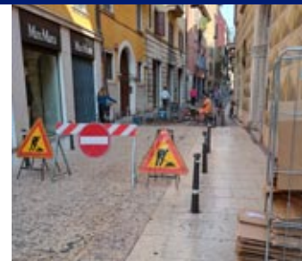
Lavori in via Quattro Spade
