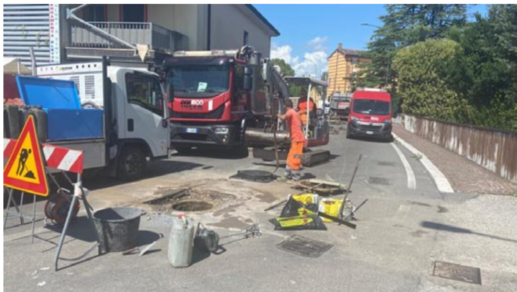
I lavori di Acque Veronesi a Castel D'Azzano
