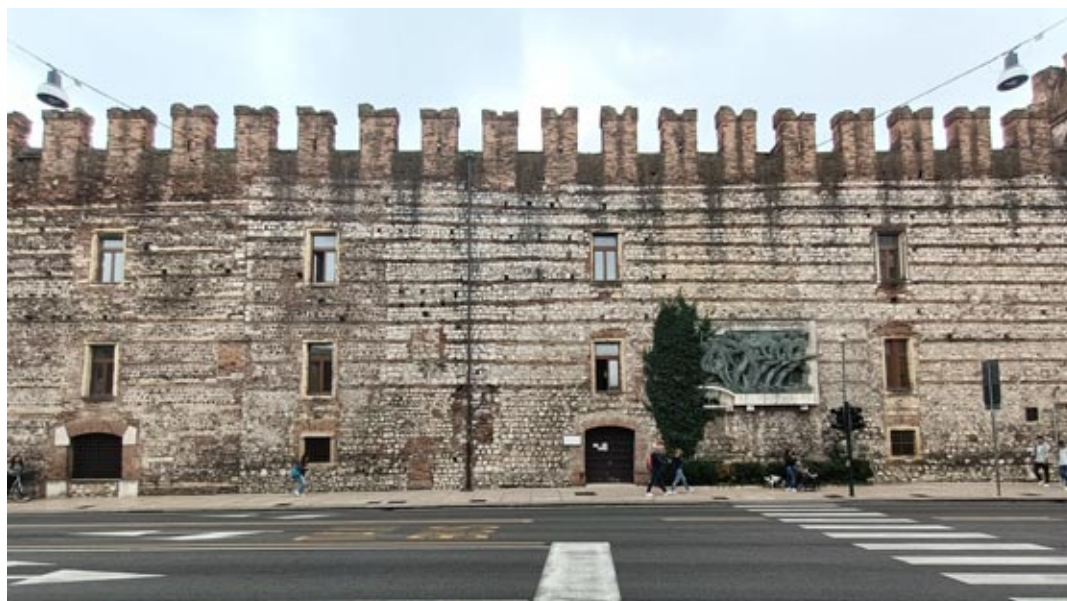
Il tratto di Mura interessato dal restauro
