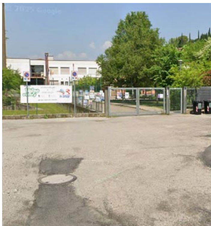
Intervento per il rifacimento dei tetti alla scuola Zorzi
