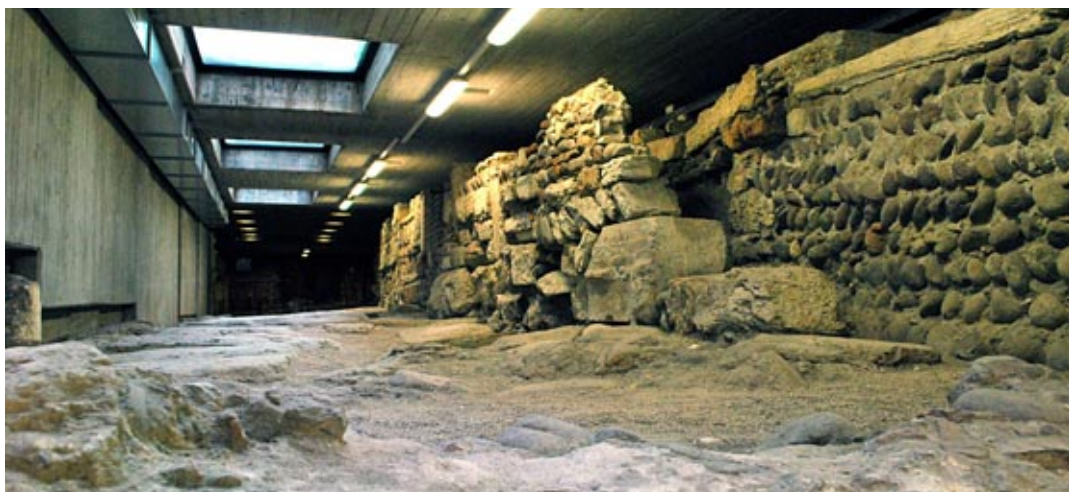
Destinati 350 mila euro per gli Scavi Scaligeri
