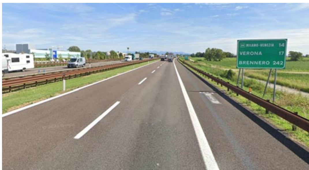
L'Autostrada del Brennero
