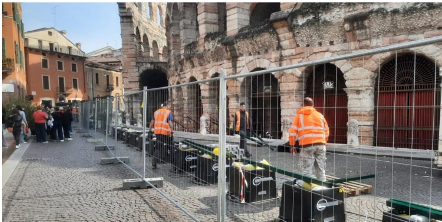
I lavori di smontaggio dopo le cerimonie olimpiche
