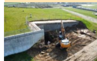
I lavori a Belfiore
