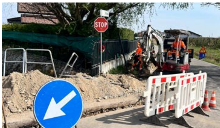
I lavori a Palù
