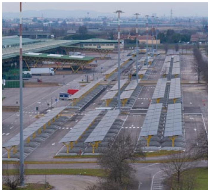
Il nuovo impianto fotovoltaico
