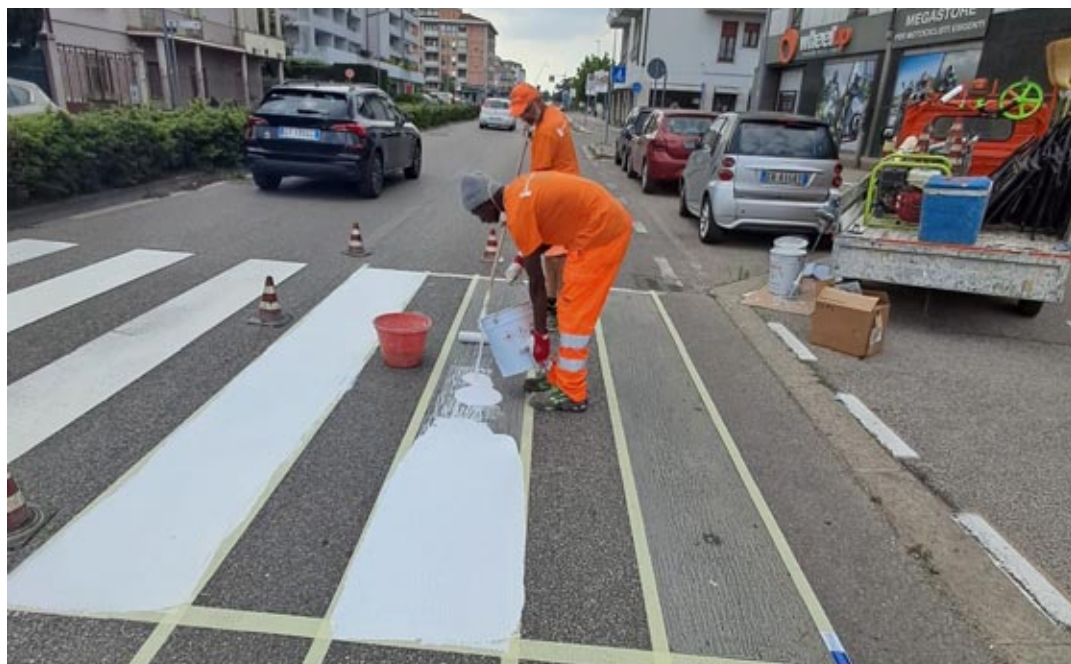
I lavori per i nuovi attraversamenti pedonali
