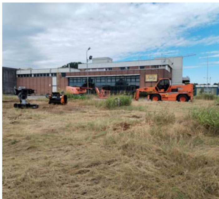
L'inizio dei lavori di recupero
